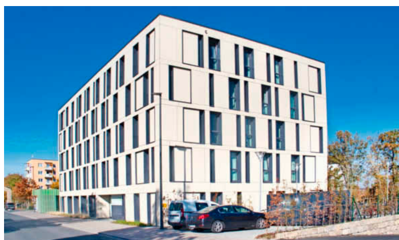
Rechtzeitig zu Semesterbeginn fertig: Das mit Kosten von 16 Millionen Euro erbaute Studentenwohnheim Green Living. Foto: Rainer Reichert
